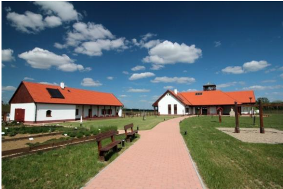
Ormánság heritage buildings
